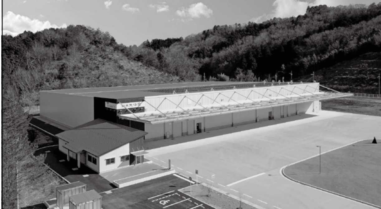
2022 年 2 月 京都府福知山市に栃本天海堂福知山工場が竣工いたしました
